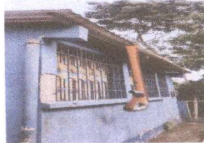
Foto 4: Reparación y mantenimiento de bajada de agua pluvial
