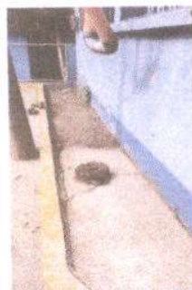
Foto 5: Reparación de banqueta de concreto por filtración de agua al salón de clase del exterior al interior. 12 m².
