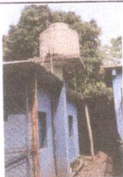
Foto 7: Reparación de base del depósito de agua ya que la existente no soportara el peso porque se aumentará la capacidad del depósito. 6 metros.
