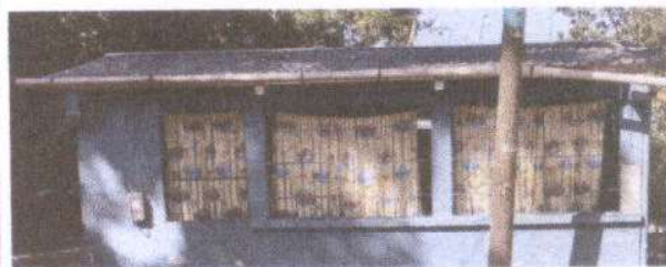
Foto 2: Mantenimiento de balcones de metal, lijado aplicación de pintura. 8 m².
