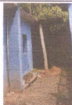
Foto 2: Puerta de lámina por una de metal, medidas de las puertas 2.00 m de altura por 1.00 m de ancho.
