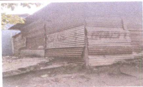
Foto9: Se realizará muro de lamina por block 6 metros de ancho por 6 metros de largo y altura 2.70 (36 m2)
