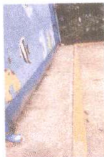
Foto 5: Reparación de banqueta de concreto por filtración de agua al salón de clase del exterior al interior. 12 m².
