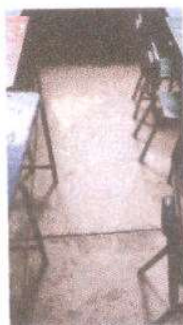
Foto 3: En aula 1, se colocará piso cerámico debido al deterioro del piso liso. Total de metros 51 m².
