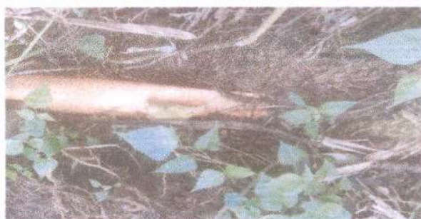
Foto 5: Reparación de red de drenaje tubería principal aguas negras
