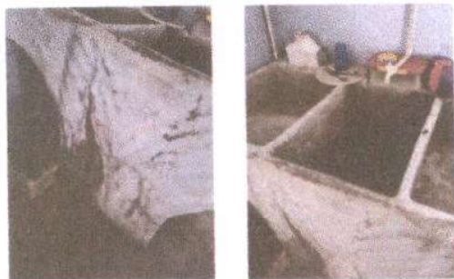
Foto 5: Se fabricará una pila de cemento de dos lavaderos por deterioro de la existente y ya no tiene reparación por el materiales de fabricación en mal estado fundida de concreto.
