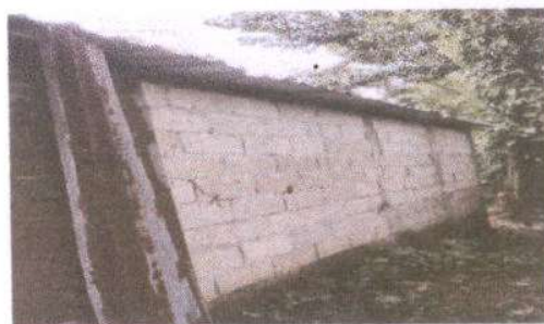
Foto 6: Se repellará la parte externa de los baños ya que se filtra agua y el deterioro es constante. 30 metros.
