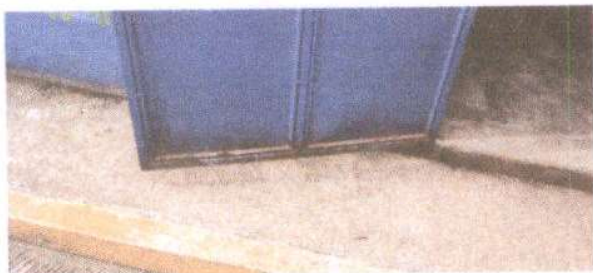
Foto 1: Reparación y mantenimiento a puerta de metal por exposición directa a la lluvia. (aula 1)
