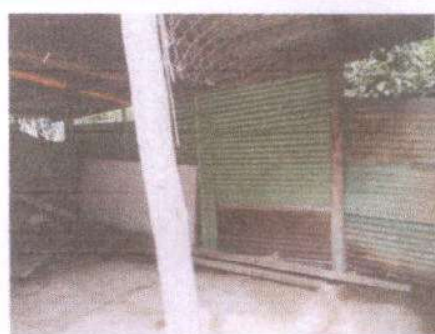
Foto 4: Pintura en muros interiores y exteriores. 60 metros
